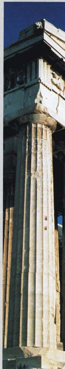
**DERECHA.** Columna de un extremo del Partenón. Las columnas eran ligeramente bulbosas para compensar los efectos de distorsión del ojo humano.
